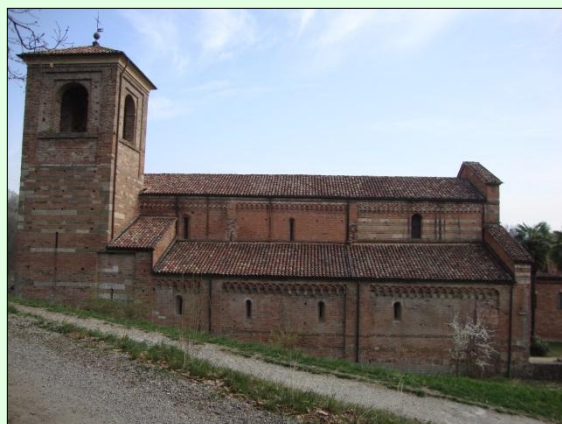
Il fianco nord della costruzione
